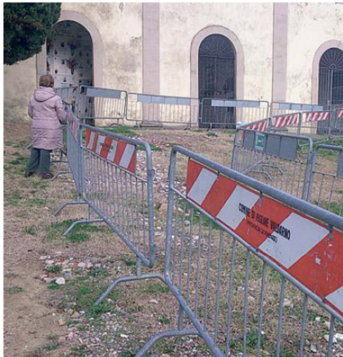
Il paradosso: la transenna sul cantiere per l'eliminazione delle barriere architettoniche, finisce per costituire una barriera in più
